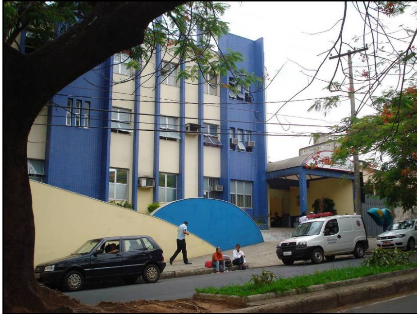
FIGURA 4: Foto externa do Hospital Mário Penna, prédio principal Fonte: trabalho de campo, 2008.
