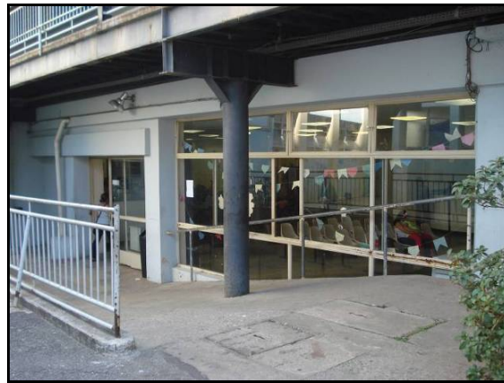
FIGURA 39: Foto da rampa SCM Fonte: Trabalho de campo, 2009.
