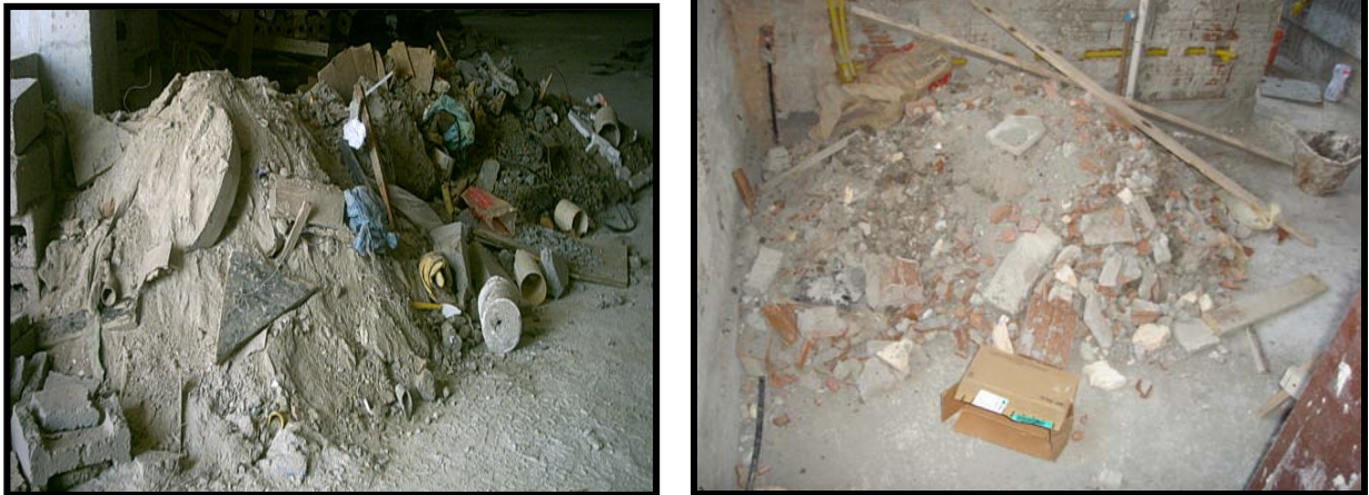
Figura 3a e 3b – Resíduos gerados na obra
