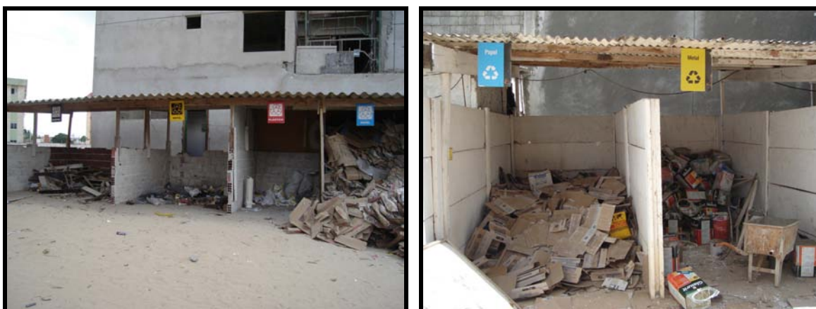
Figuras 29a 29b – Acondicionamento final do resíduo no canteiro de obras (separados por baias)
