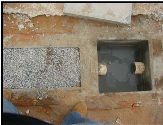
Fotos 31a e 31b – Prática de sustentabilidade no canteiro de obras – Reaproveitamento de água da betoneira
