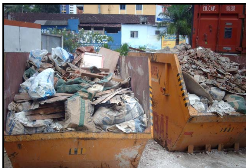
Figura 35 – Acondicionamento final no canteiro (todos os resíduos misturados)
