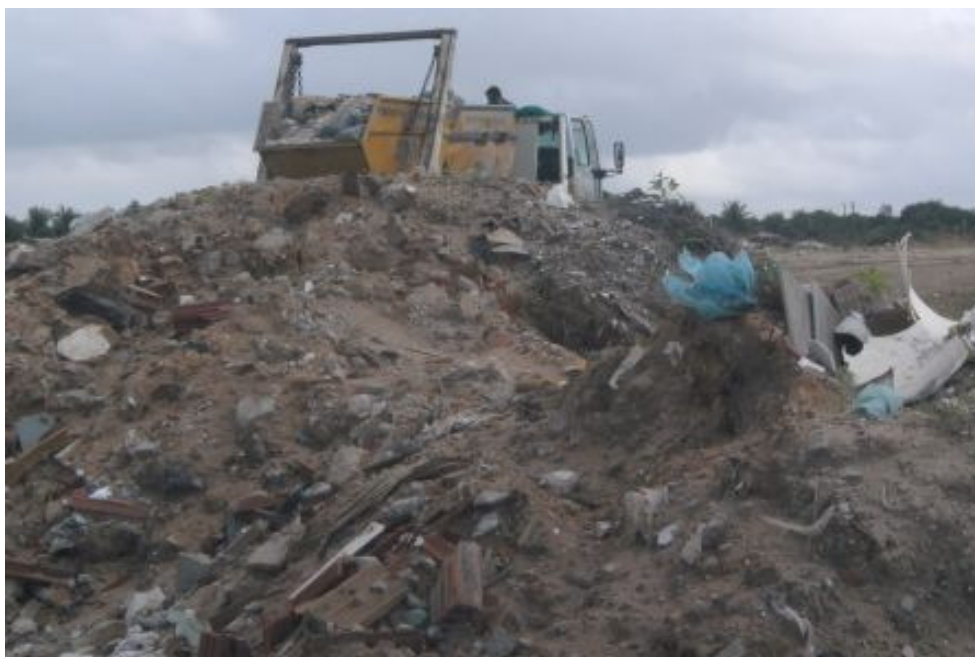
Figura 2.2: Caçamba metálica realizando despejo final de RCD (Área de deposição da Prefeitura Municipal de Parnamirim – Antigo Lixão – Proximidades do Bairro da Liberdade).
