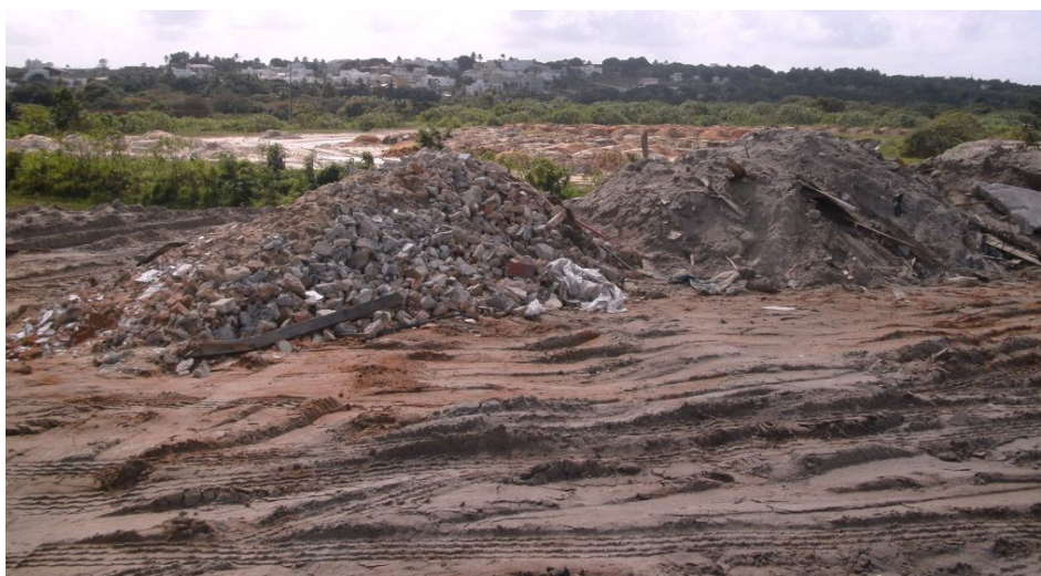
Figura 4.3: Reutilização de RCD para aterramento e compactação de solo. Fonte: SANTOS (2009).
