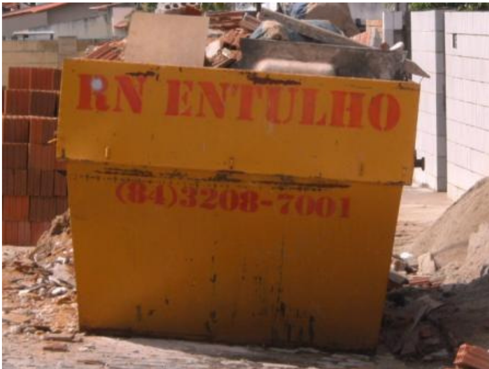
Figura 2.1: Caçamba metálica estacionária para coleta de RCD (Rua Serra do Arapuá – Nova Parnamirim – Parnamirim/RN).
