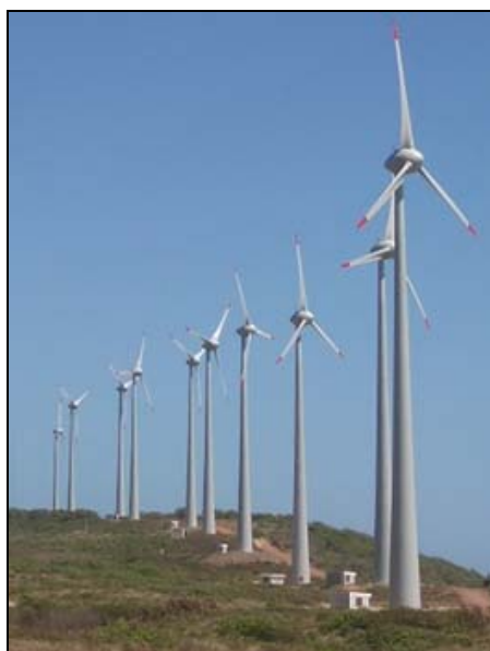
Figura 5.11 - Central Geradora Eólica Millennium, Mataracá, PB.
