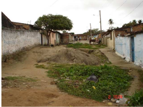
FIGURA 05 - Rocha existente na Rua Santos Fonte: UEM (2004)
