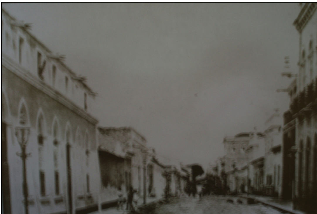
Figura 5 - Bocas de Jacaré na Rua da Palma.
