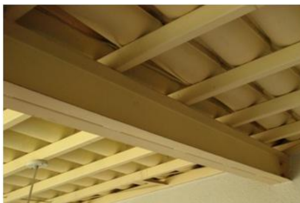
Figura 2.8 – Viga com seção tipo “I” formada pela união de perfis do tipo U simples (Arquivo pessoal)
