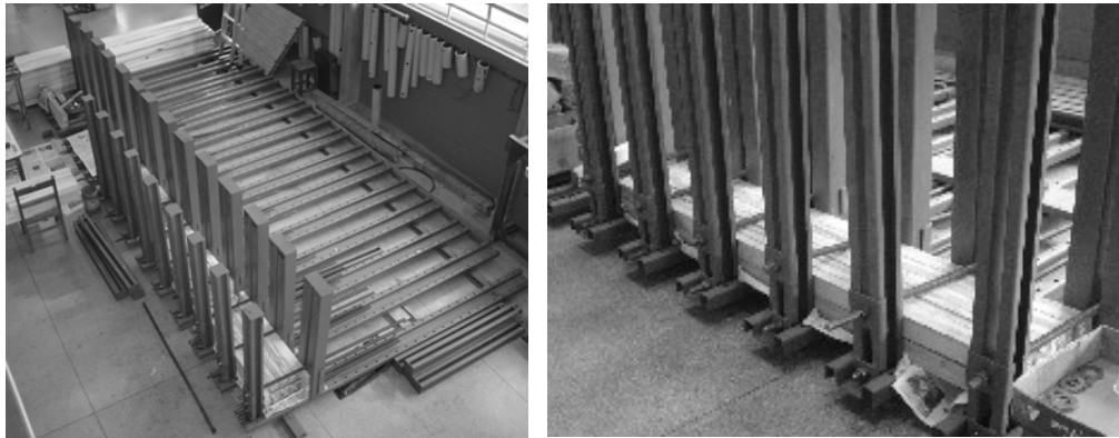
Figura 5.1 – Prensagem das vigas de MLC.
