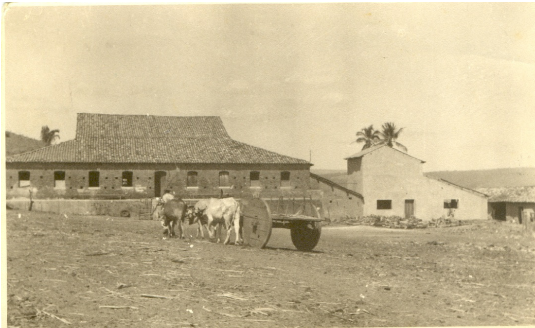
Foto 1 - Vista frontal da Casa e Engenho Tupinambá . Os volumes caiados de branco, à esquerda, acrescentados por Elony Sampaio por volta de 1950, funcionavam como armazém, casa do alambique e oficina. Fotografia atribuída a Elony Sampaio. Arquivo Yacê Carleial.
