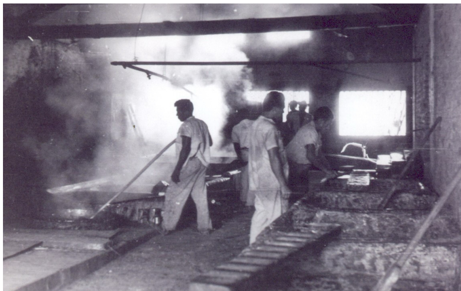
Foto 20. Sala da fornalha do Tupinambá , após a unificação da linha de cozimento nos anos 1960. Em primeiro plano, à direita, o caixamento. Fotografia: Autor desconhecido. (APYS)
