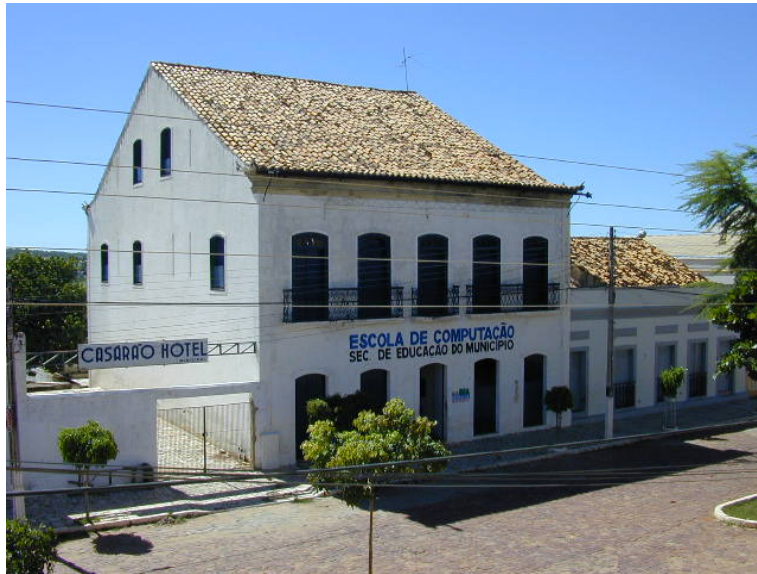
Foto 4. Sobrado da Rua da Matriz, volume e fachada principal. Fotografia IPHAN.
