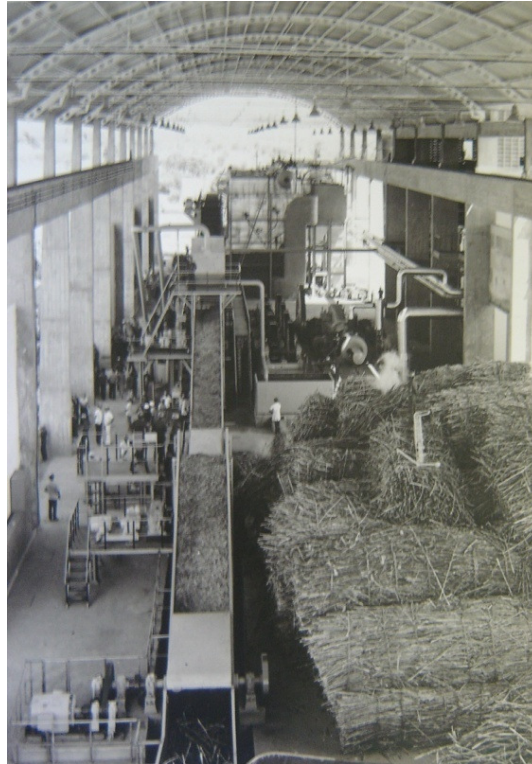
Foto 24 - Máquinas carregadoras no manejo das primeiras canas na Usina na inauguração festiva em 14 de julho de 1976. Fotografia: Arquivo Usina Manoel Costa Filho. (AUMCF)
