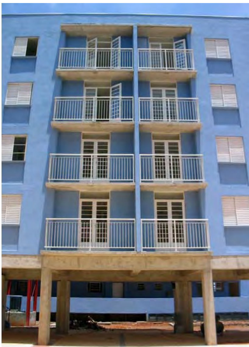
FIGURA 3.24 Detalhe das varandas em edifício do Parque do Gato. Fonte: Arquivo da autora, 2004.
