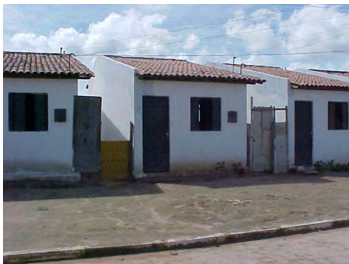
FIGURA 3.4 Conjunto habitacional Denisson Menezes em Maceió, Alagoas. Fonte: Cedido pela Secretaria Municipal de Habitação do município de Maceió. 2007.
