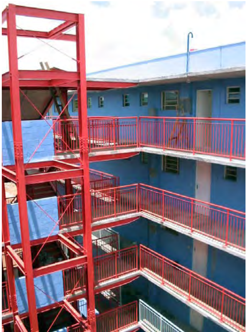
FIGURA 3.26 Estrutura metálica para receber elevador no futuro em edifício do Parque do Gato. Fonte: Arquivo da autora, 2004.
