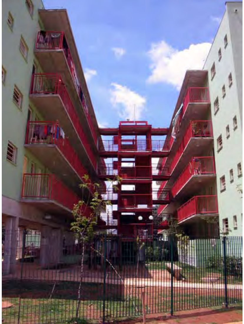
FIGURA 3.25 Circulação vertical e horizontal no empreendimento Parque do Gato. Fonte: Arquivo da autora, 2004.
