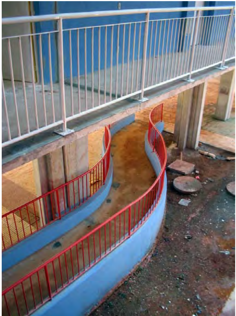
FIGURAS 3.27 e 3.28 Rampa de acesso ao primeiro pavimento de edifício no empreendimento Parque do Gato. Fonte: Arquivo da autora, 2004.
