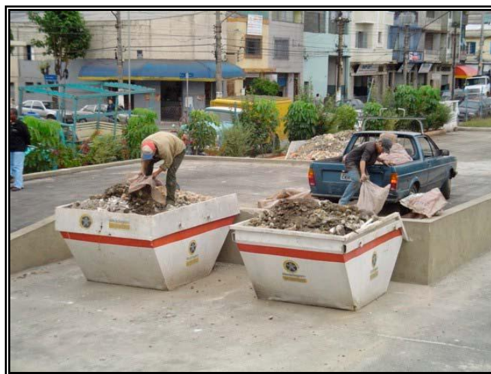
Figura 4: Ponto de entrega para pequenos volumes de resíduos na cidade de São Paulo – SP.
