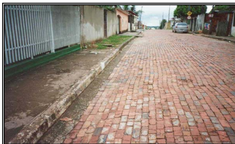
Figura 6: Pavimento de blocos de argila na cidade de Rio Branco – AC.
