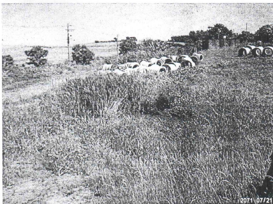
Foto 12 - Pequena lagoa formada por água proveniente do dreno rompido. Nota-se ao fundo diversos tubos de concreto, os quais, segundo os moradores, serviriam para o escoamento de águas pluviais quando instalados.
