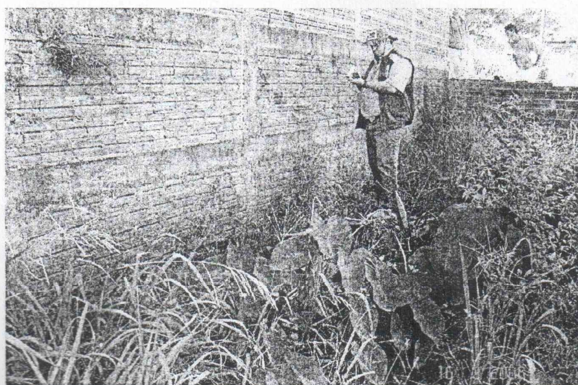
Foto 4 - Vê-se a presença de pteridófitas (samambaias) de médio porte que brotaram e se desenvolveram a mais de 1,0 m de altura no muro, denotando que a presença de água constante no local.
