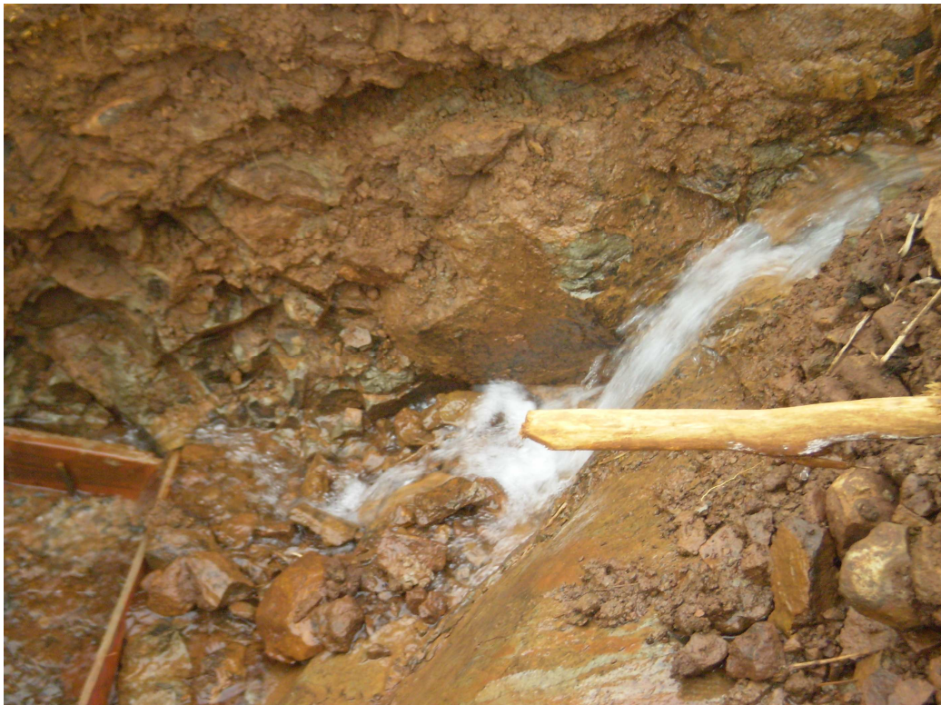
Fotografia 6 – Surgência do lençol freático no Tarumã II – 1. Fonte: Matievecz (Dez. 2005).
