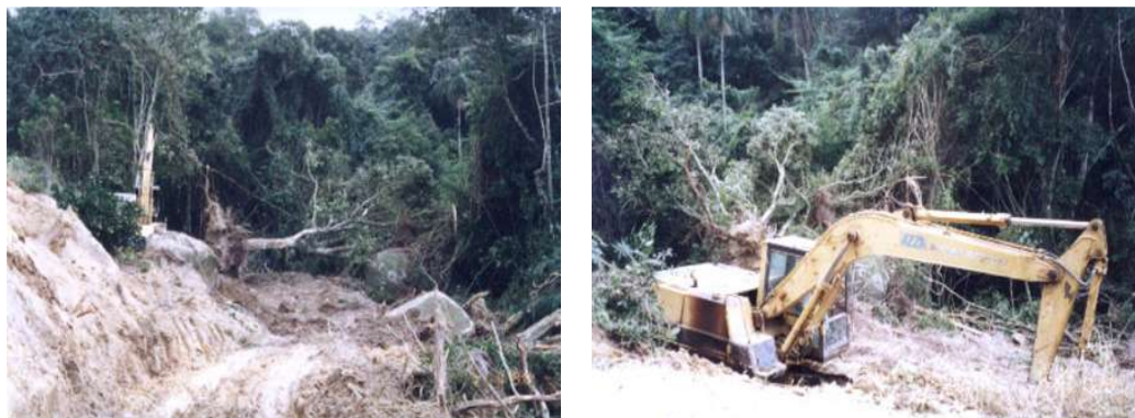
Figura 4: Processo de construção da Avenida Interpraias. Fonte: Associação Ecológica Taquaras.
