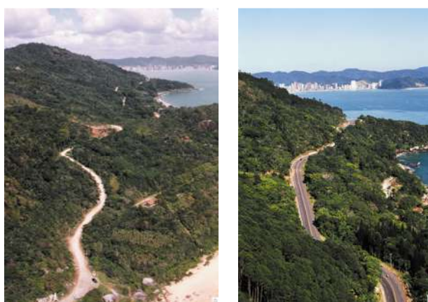
Figura 5: Avenida Interpraias, à esquerda antes da melhoria, à direita com o asfaltamento. Fonte: Arquivo Histórico de Balneário Camboriú.
