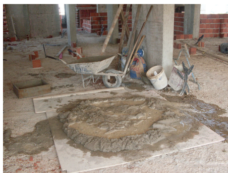
Foto 5 - Ferramentas e massa de reboco. Fonte: BATISTA, José Roberto, Trabalho de Campo, 2009 – 2010.
