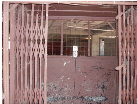
Foto 8 - Elevador da Obra. Fonte: BATISTA, José Roberto, Trabalho de Campo, 2009 – 2010.
