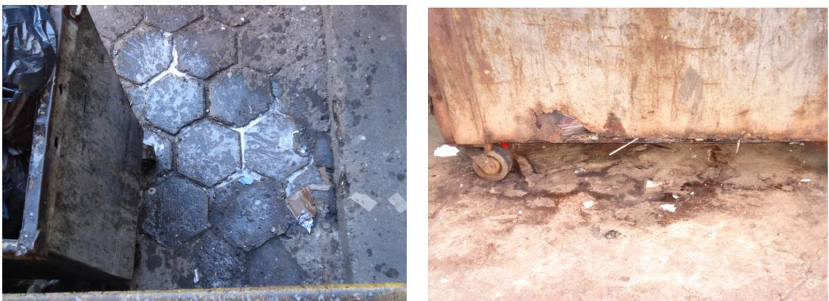
Figura 24 – Vazamento de chorume no pátio do Cais e contêineres mal conservados
