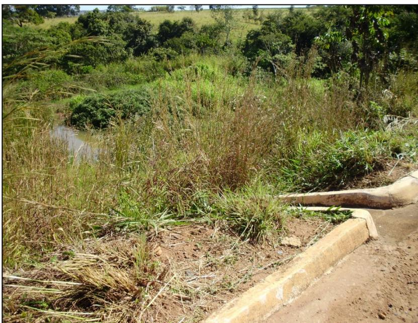
Figura 5.20 – Calha que conduz os resíduos da rodovia para um dos afluentes do Ribeirão João Leite.
