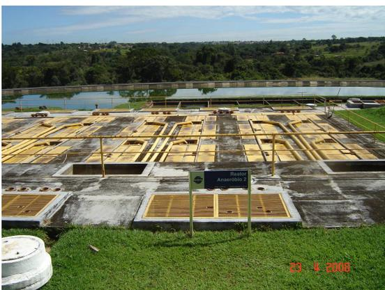
Figura 4.2.2 Vista parcial dos reatores UASB - ETE Lages
