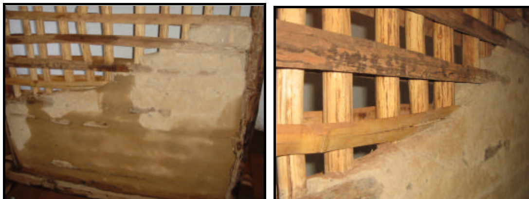
Figura 28 - Modelo de uma parede de Taipa de pau-a-pique no quarto de nº 3 do Museu José Antônio Pereira.
