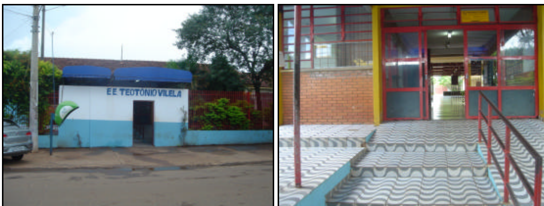
Figura 70 - Vista parcial da Escola Estadual Teotônio Vilela (2009).
