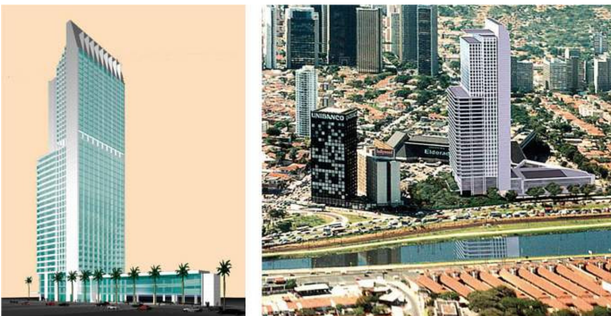
FIGURA 55- 6ª versão Os dois itens do programa da torre - escritório e hotel - ganham certa independência e possibilitam essa leitura para o observador externo. As fachadas maiores adquirem pequenas curvas - como Aflalo tinha proposto em seu primeiro estudo. Fonte: http://www.arcoweb.com.br , 2008
