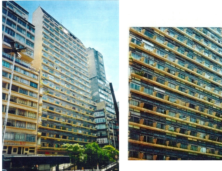
FIGURA 37 - Edifício Normandie, SP, 1953 – Arquiteto Franz Heep. Fachada e detalhe de caixilhos, sacadas. Fonte: BARBOSA, 2002.
