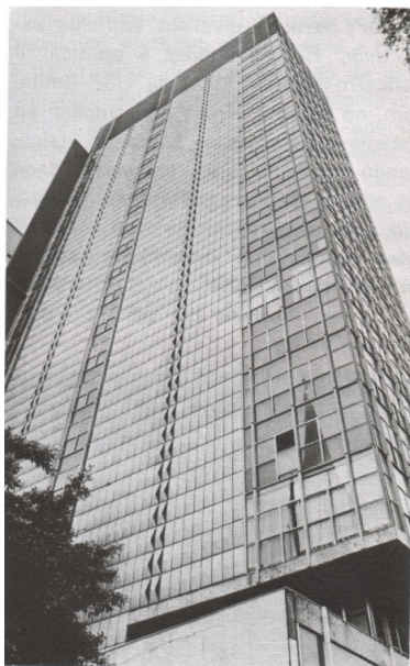
FIGURA 44 - Edifício Wilton Paes de Almeida, SP, 1961. Um dos primeiros edifícios a empregar a solução “ curtain-wall ”, associando-a a painéis pré moldados de alumínio, o que determina a redução das bordas da laje, de modo a resultarem extremamente delgados os perfis da caixilharia. Arquiteto Roger Zmekohl. Fonte: XAVIER; LEMOS; CORONA, 1983.
