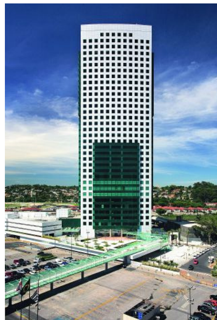
FIGURA 61- Passarela de acesso ao Shopping Eldorado. Fonte: http://www.arcoweb.com.br , 2008.
