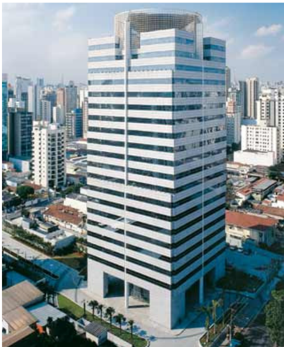
FIGURA 22 - Figura Edifício New Century – São Paulo – Apresentação Nelson Kawakami – cte, 2008. Foto: Nelson Kon
