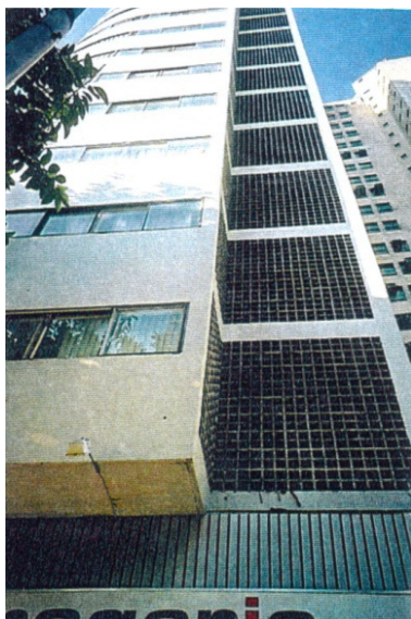
FIGURA 40 - Edifício Iporanga, SP, 1956. Arquiteto Franz Heep – Detalhe de elemento vazado. Fonte: BARBOSA, 2002.
