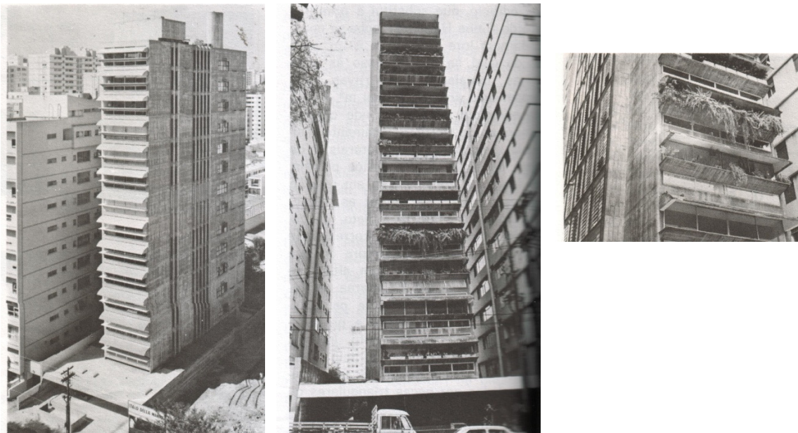
FIGURA 42 - Edifício Gaimbé, SP, 1964, de Paulo Mendes e João de Gennaro. Fonte: XAVIER; LEMOS; CORONA, 1983.
