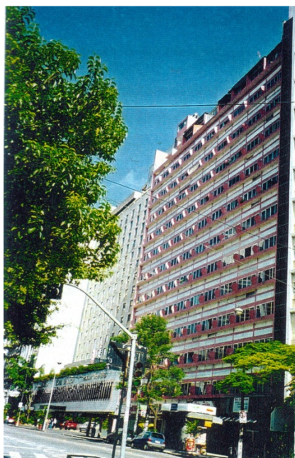
FIGURA 38 - Edifício Arapuan, SP, 1953. Arquiteto Franz Heep – Fachada e detalhe de caixilhos, sacadas. Fonte: BARBOSA, 2002.
