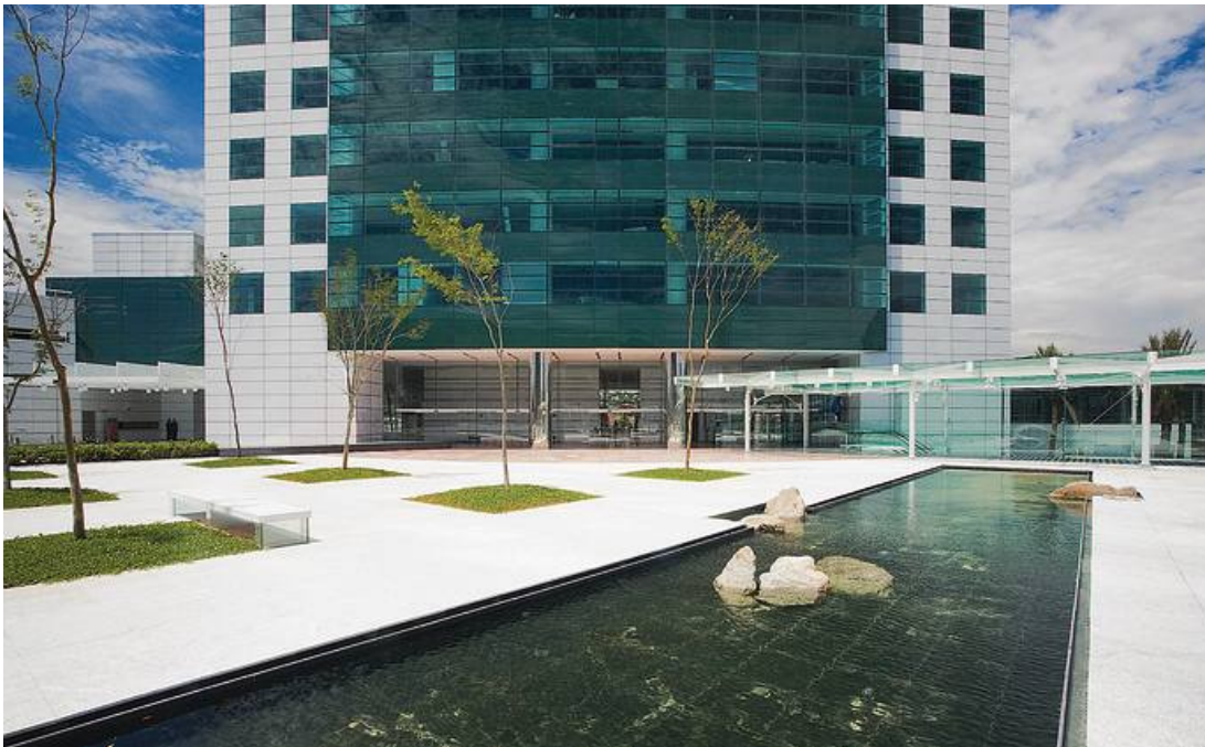
FIGURA 69- Vidros da Fachada. Fonte: Revista Técnica 2008.
