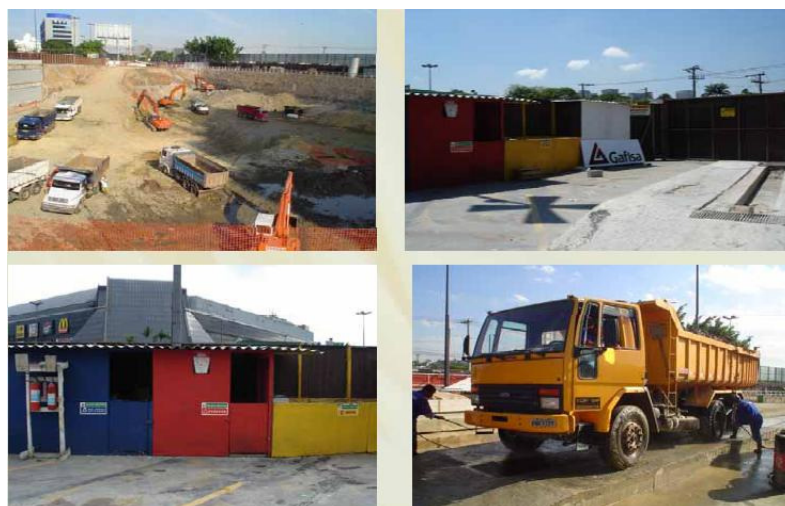
FIGURA 74– Canteiro de Obras: Gafisa, 2009.
