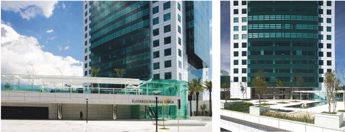
FIGURA 58 E FIGURA 59 - Vista a partir da rua: o volume de vidro contém escadas rolantes, que ligam a praça baixa, na cota da via, à praça elevada, no térreo do edifício. Fonte: http://www.arcoweb.com.br , 2008.
