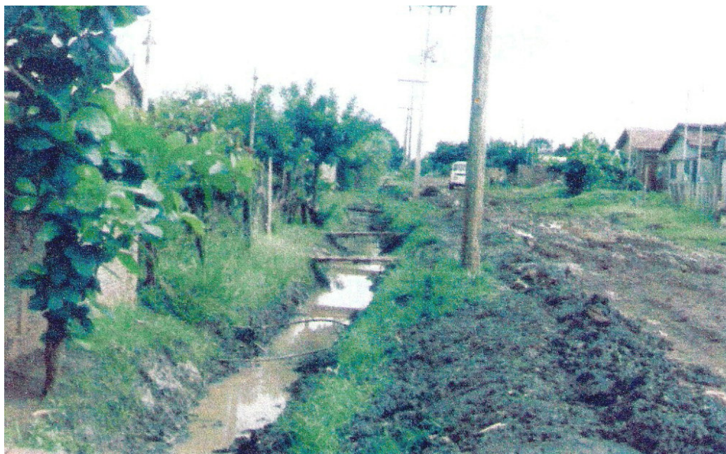
VILA CACHOEIRINHA ANTES: valetas para escoamento das águas servidas de precárias pontes.
