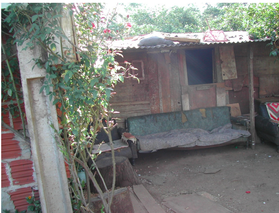
Barraco construído às margens do córrego Água Boa. Em épocas de chuvas, a água do córrego transborda entrando nos barracos. (Região da Vila Cachoeirinha). Foto: Maria Amábili Alves de Castro - 2004
