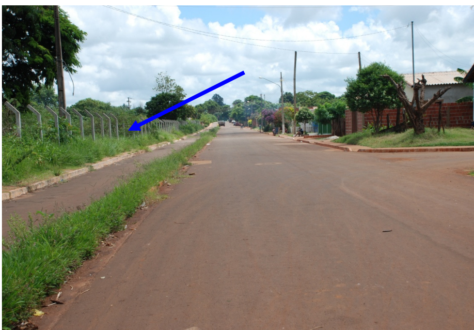
VILA CACHOEIRINHA DEPOIS: Via Parque que interliga os bairros da área, construída após a demolição das casas e barracos. No detalhe, cerca ao longo do córrego Água Boa. Foto: Maria Amábili Alves de Castro - 2009
