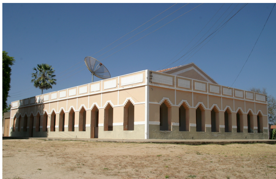
Foto 11 – Casarão construído em 1940, comunidade de Pitombeira I, Russas-CE. (Foto: Mauro Angeli)
