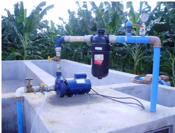
Figura 7 – Cabeçal de controle da irrigação e da fertirrigação utilizado na realização do experimento.
