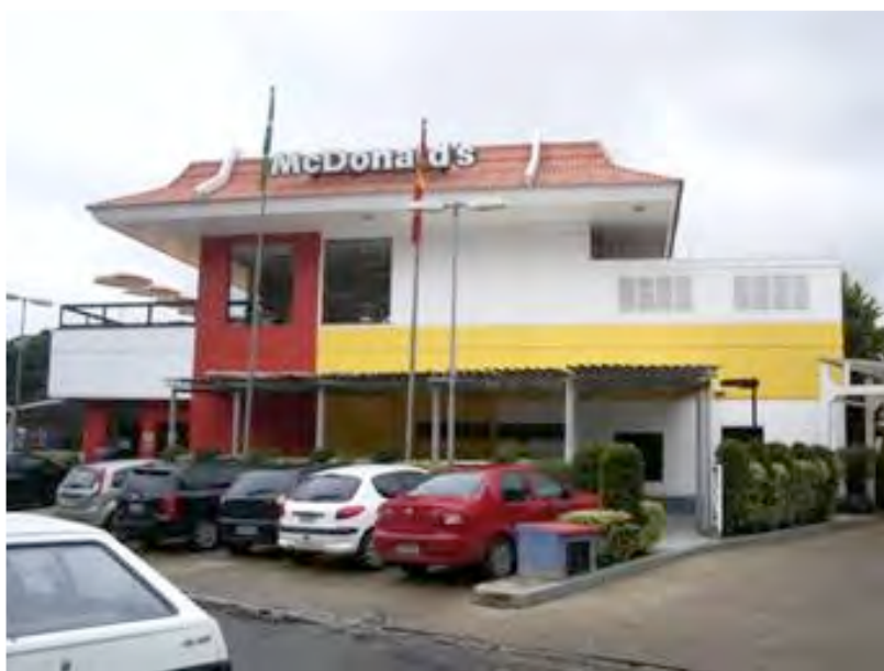
Figura 43: Fachada da loja McDonald's na Granja Viana, Brasil, antes da reforma.
