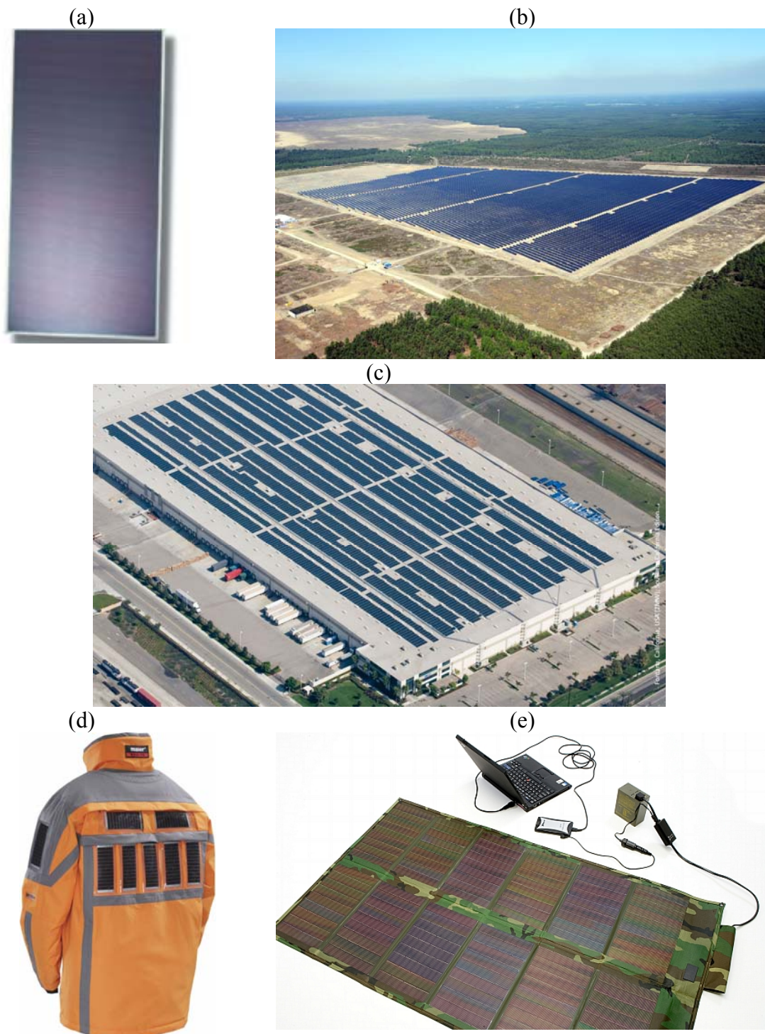
FIG.1.4 (a) Módulo de CdTe FS-277, com 1,2 \times 0,6 \text{ m}^2 , 12 kg, 77,5 W de potência nominal, 69,9 V de tensão e 1,11 A de corrente em potência máxima (FIRST SOLAR, 2009); (b) planta solar em Lieberose, Alemanha, com capacidade de 53 MW, com 700 mil módulos da FS-272-277 (FIRST SOLAR, 2009); (c) BIP de 2 MW, com 33 mil e 700 módulos de CdTe no teto de um depósito, na Califórnia, EUA (FIRST SOLAR, 2009); (d) protótipo de jaqueta com células integradas de silício amorfo com uma potência de 2,5 W (SCHUBERT e WERNER, 2006); (e) módulo flexível de CIGS para emprego em campo, de 48 W (GLOBAL SOLAR, 2009).
