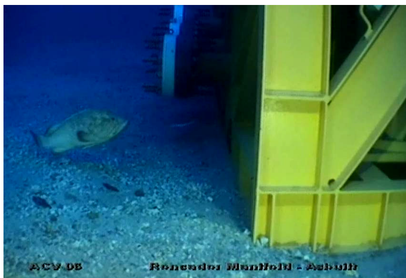
Figura 21. Inspeção submarina: manifold sendo inspecionado por habitante local (Cortesia de Petrobras)
