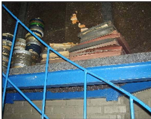
Figura 3- O piso do acervo sem proteção
