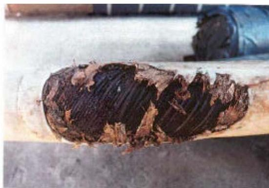
Figura 5: Ruptura generalizada da capa externa (COSTA, 2002).
