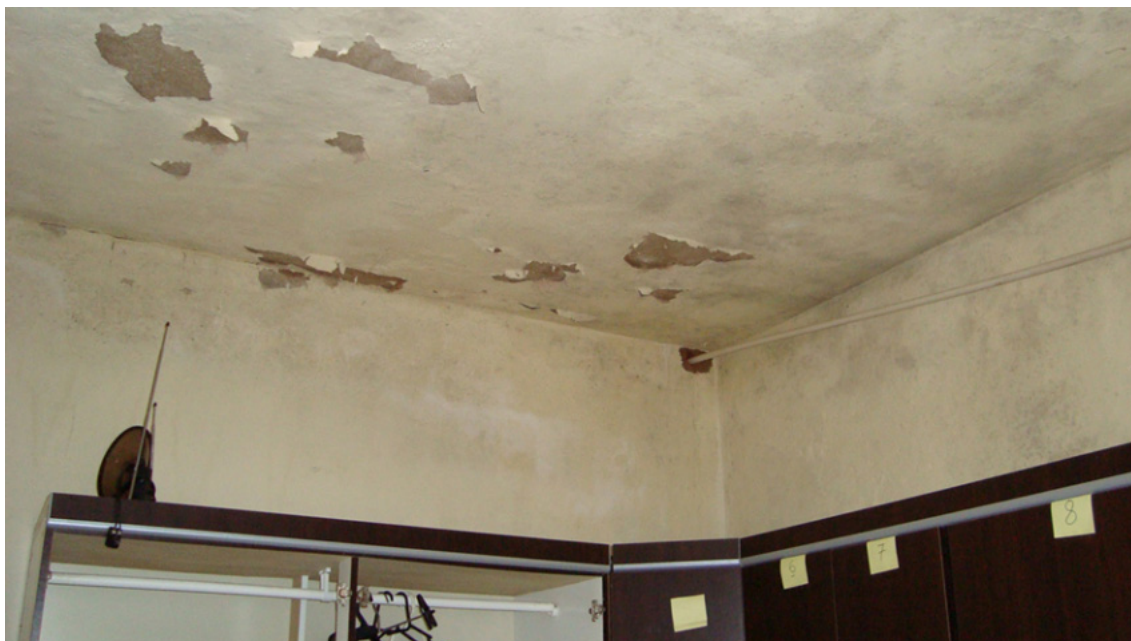
FIGURA 30 – Laje do quarto do casal
