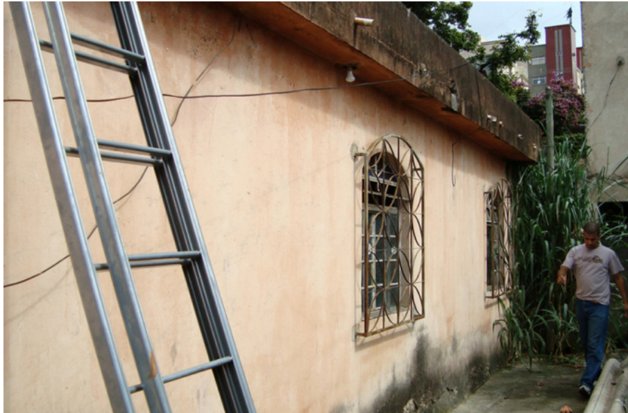
FIGURA 27 – Residência Hilda e Marcelo, bairro Santa Tereza, Belo Horizonte Fonte: arquivo particular dos arquitetos Hernán Espinoza e Janaína Marx, 2009.
