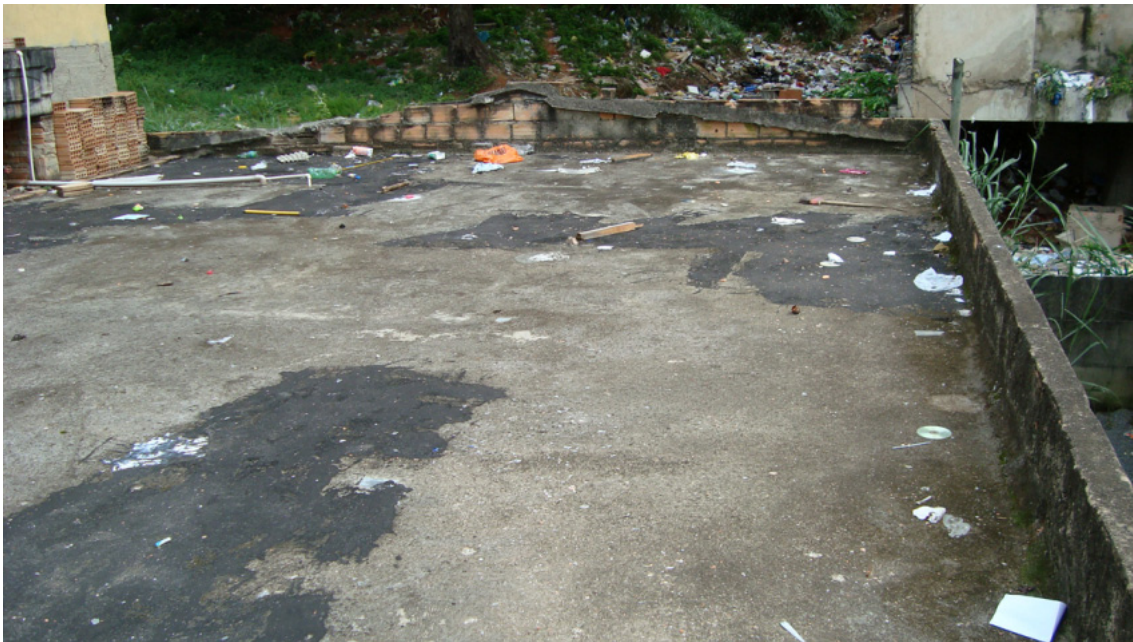
FIGURA 32 – Vista da laje.
