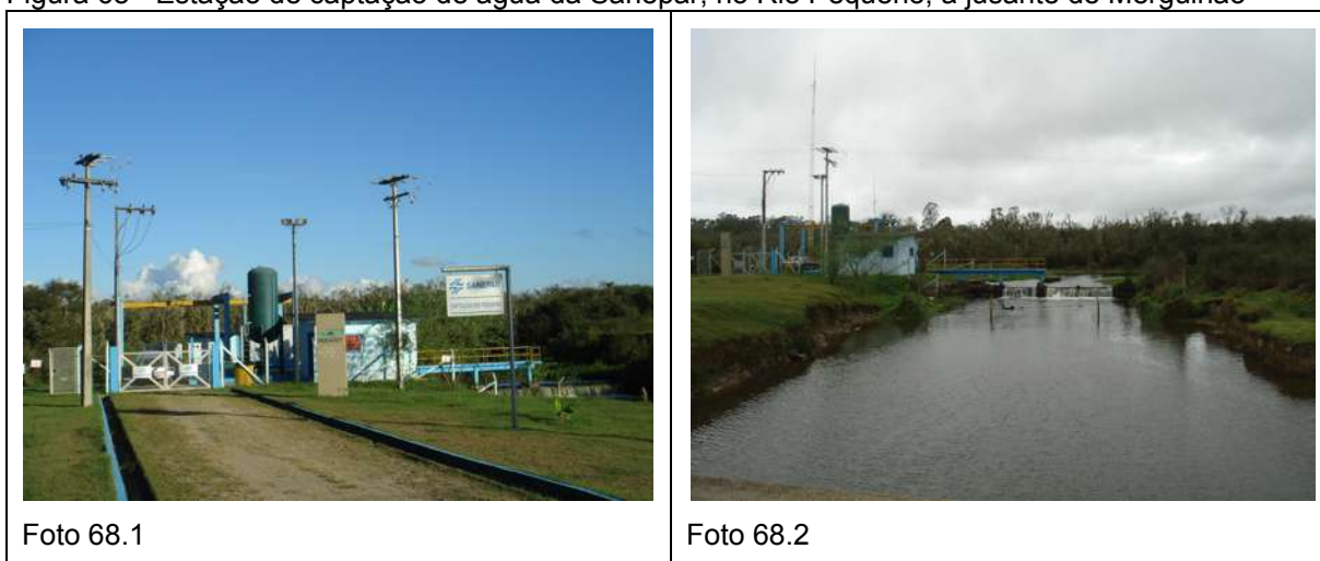
Figura 68 - Estação de captação de água da Sanepar, no Rio Pequeno, a jusante de Mergulhão
