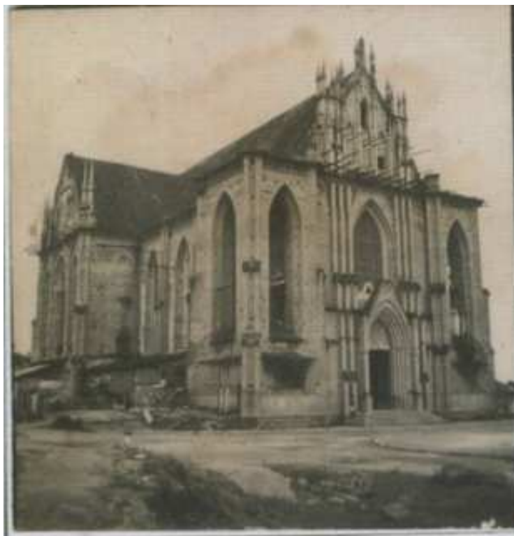
Figura 10 – Catedral em obras s/d. Arquivo da Cúria Metropolitana de Vitória.
