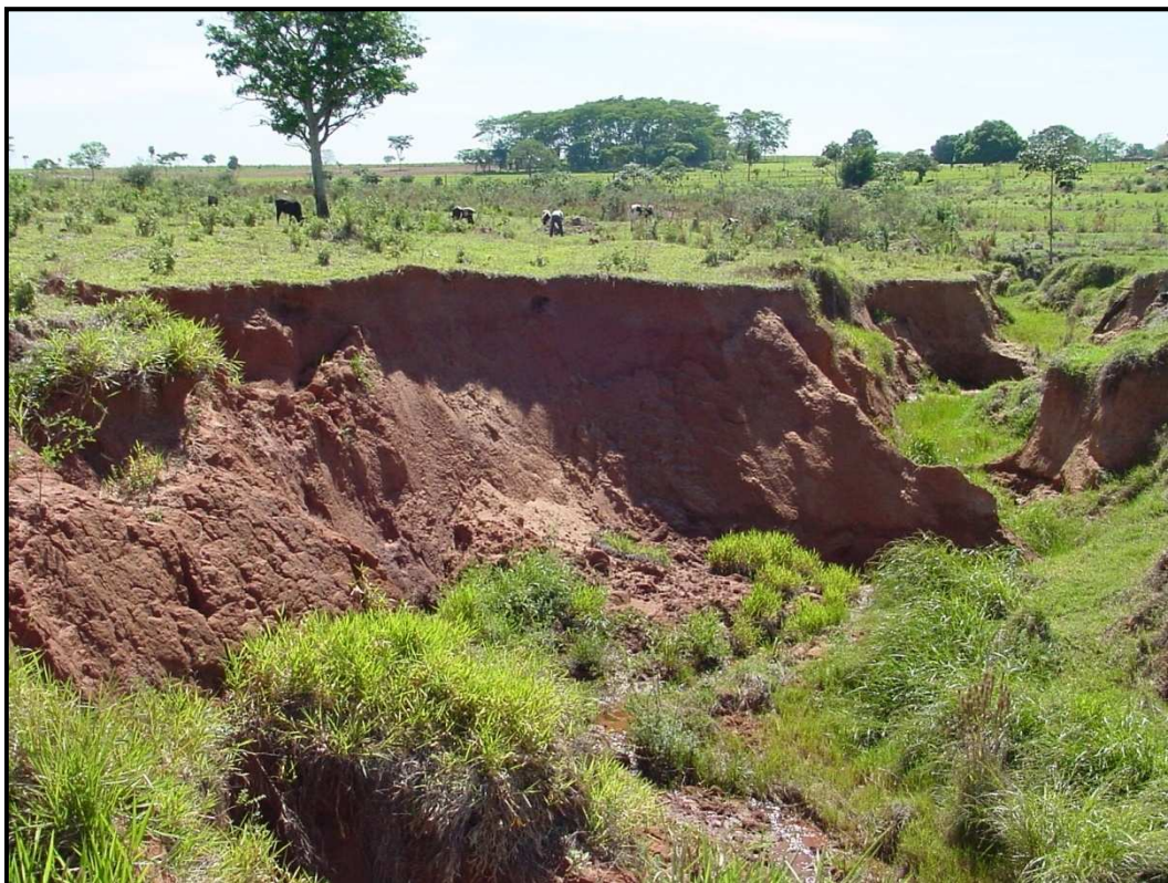
FIGURA 21 – Voçoroca observada no município de Glória de Dourados- MS. Fonte: Nunes (2004).
