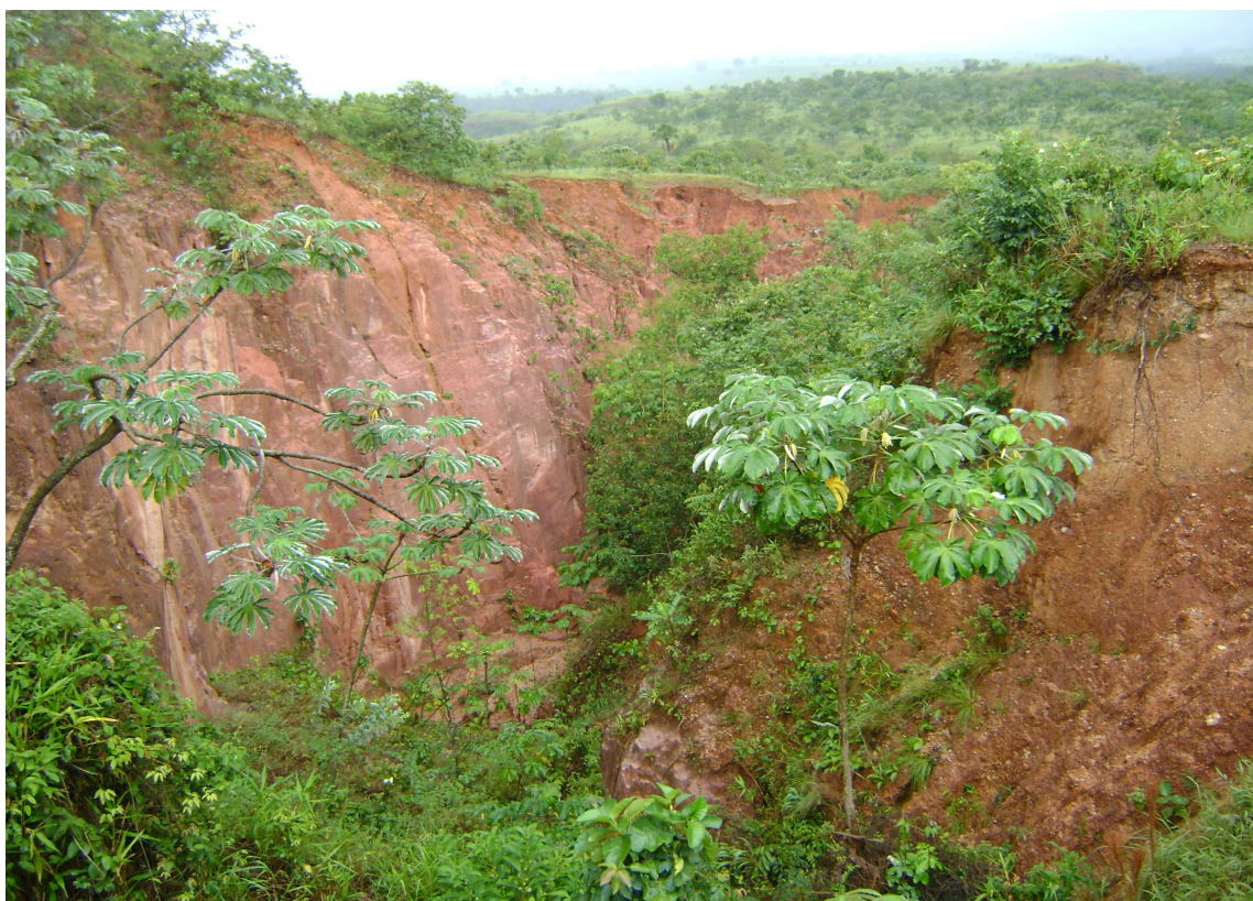
Figura 21 – Vista parcial de voçoroca na Serra das Parnaíbas, próxima às cabeceiras do córrego Cambaúva, cujo material afetado é constituído por depósitos do Carbonífero da Formação Aquidauana.
