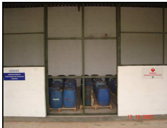
Figura 13 – Área central de armazenamento temporário de resíduos. Fotografia: Fábio E. Penatti, jan, 2006.
