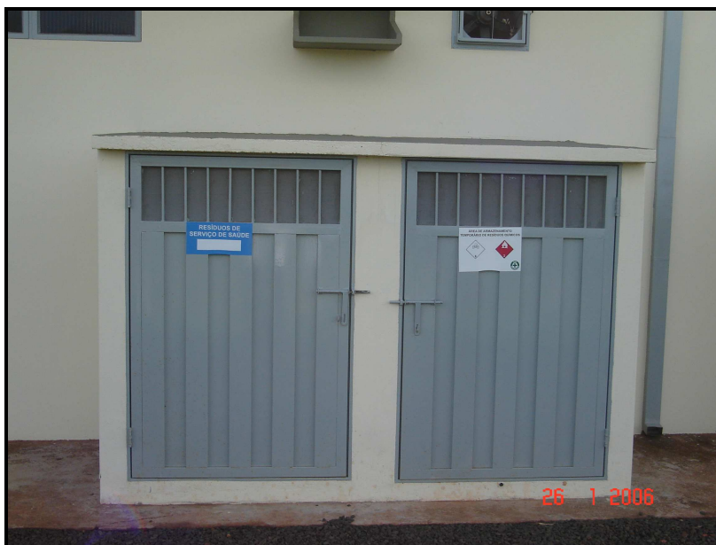
Figura 10 - Locais externos de armazenamento de resíduos dos laboratórios de microbiologia. Fotografia: Fábio E. Penatti, abril, 2009.
