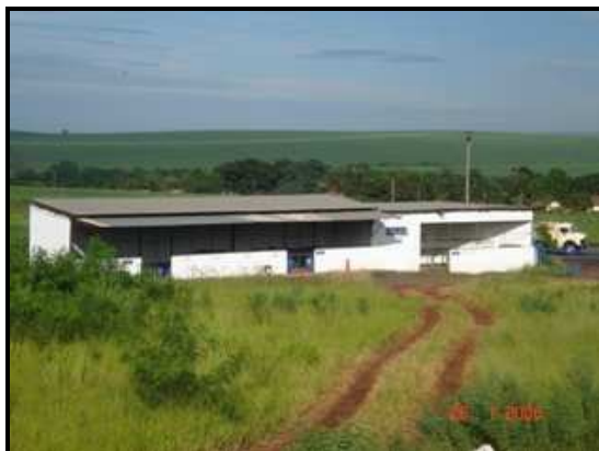
Figura 12 – Área central de armazenamento temporário de resíduos. Fotografia: Fábio E. Penatti, jan. 2006.
