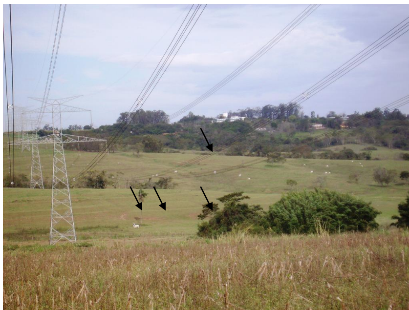
Foto 16 - Áreas de Pastagem ao sul da bacia do ribeirão Alam Grei, apresentando formas erosivas.
