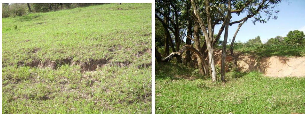
Fotos 21 e 22 – Feições que indicam a ação dos processos erosivos encontradas no bairro do Alam Grei.
