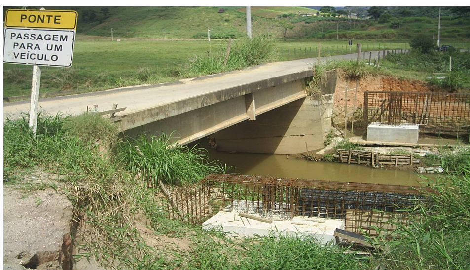
Foto datada de 2006, após início das obras de reestruturação e em 2008 ainda permanece como a imagem revela
