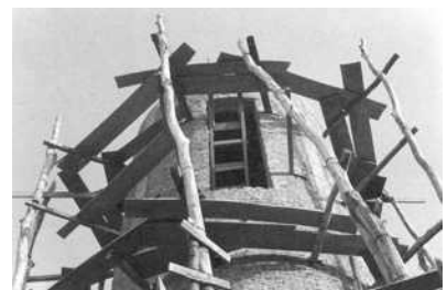
FIGURA 72 – Vista do campanário em obra, com andaimes improvisados.
