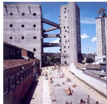
FIGURA 132 – Vista do deck-solarium. Fonte: LATORRACA, 1999, p. 90
