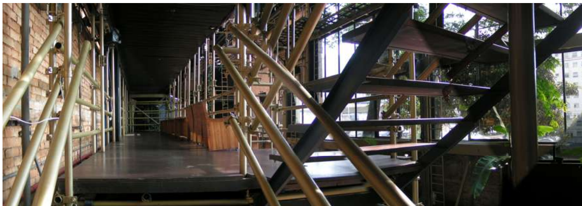
FIGURA 156 – Vista de uma das galerias do Teatro Oficina.
