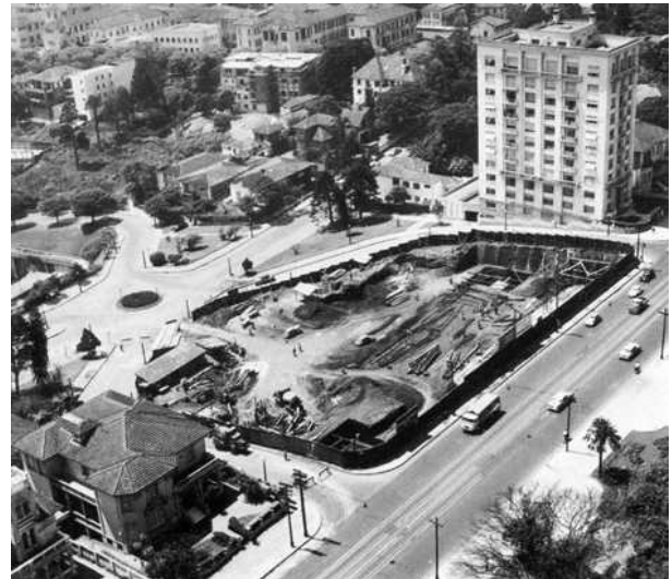
FIGURA 13 – Vista geral da Av. Paulista, com o antigo edifício Trianon demolido. Fonte: FERRAZ, 2008, p. 102
