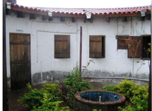
FIGURA 77 – Vista do pátio interno da residência das freiras.
