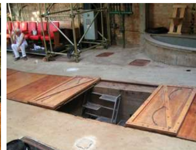
FIGURA 166 – Vista do alçapão aberto. Fonte: Foto do autor, 2009
