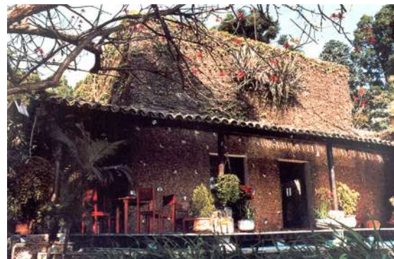
FIGURA 24 – Vista da varanda da casa Valéria Cirell, em 1996.
