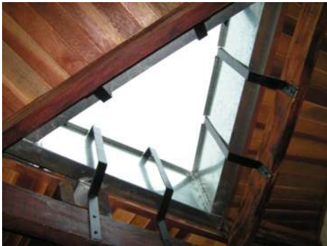
FIGURA 85 – Detalhe da iluminação zenital na circulação da residência das freiras.
