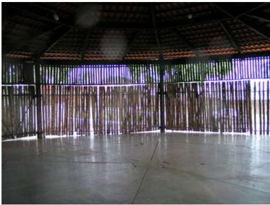
FIGURA 91 – Vista interna do galpão. Fonte: Foto do autor, 2009
