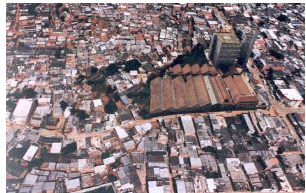
FIGURA 136 – Vista geral do entorno do SESC Pompéia. Fonte: LATORRACA, 1999, p.11
