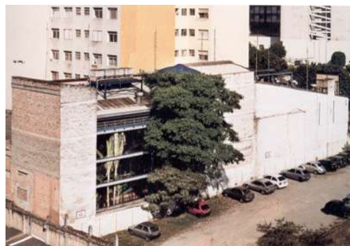
FIGURA 152 – Vista de uma das fachadas laterais do Teatro Oficina. Fonte: OLIVEIRA, 2002, p. 185
