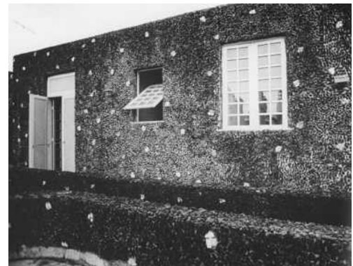
FIGURA 22 – Detalhe do terraço da casa do Chame-Chame.
