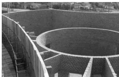
FIGURA 71 – Vista das paredes, em obra.
