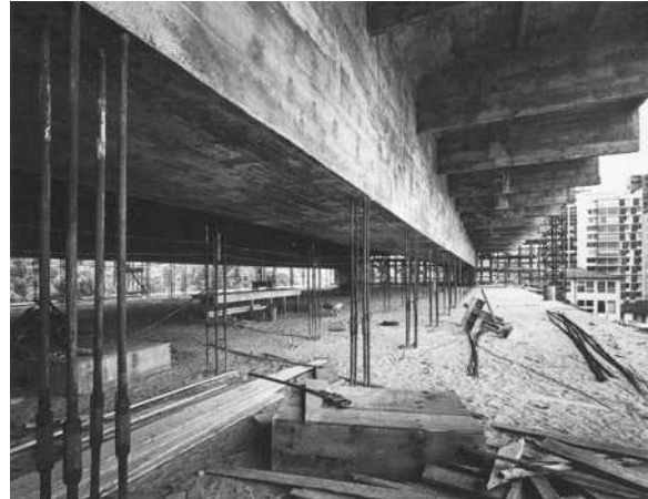
FIGURA 39 – Vista da viga principal com os tirantes de sustentação do primeiro andar.
