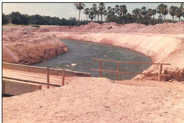
Figura 25. Desvio do canal do rio Quixeré para construção da barragem das Pedrinhas
