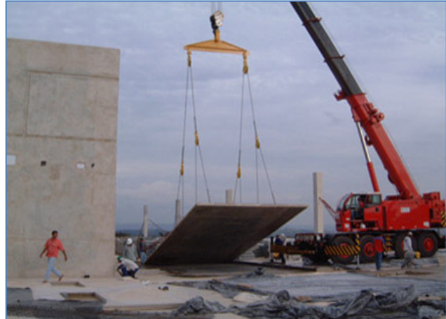
Figura 3-6 – Painéis Tilt-Up (fonte: WTORRE Engenharia)
