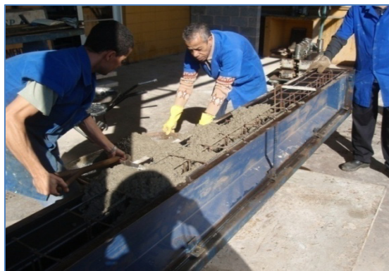
Figura 7-21 – Adensamento sobre mesa vibratória
