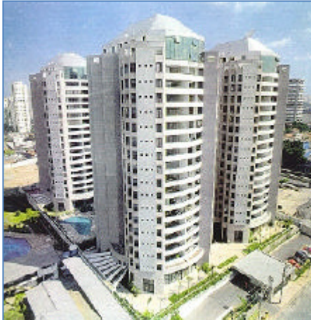
Figura 3-5 – Empreendimento Condominium Club Ibirapuera (fonte: Método Engenharia)
