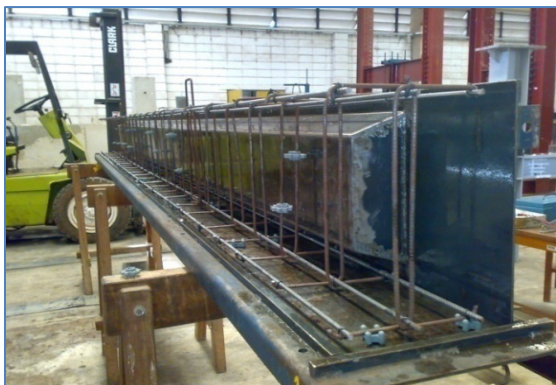
Figura 7-20 – Armação e fôrma da Viga
