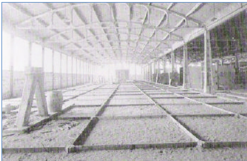
Figura 3-4 – Galpão Industrial com vigas Vierendeel de concreto armado (VASCONCELOS, 2002).
