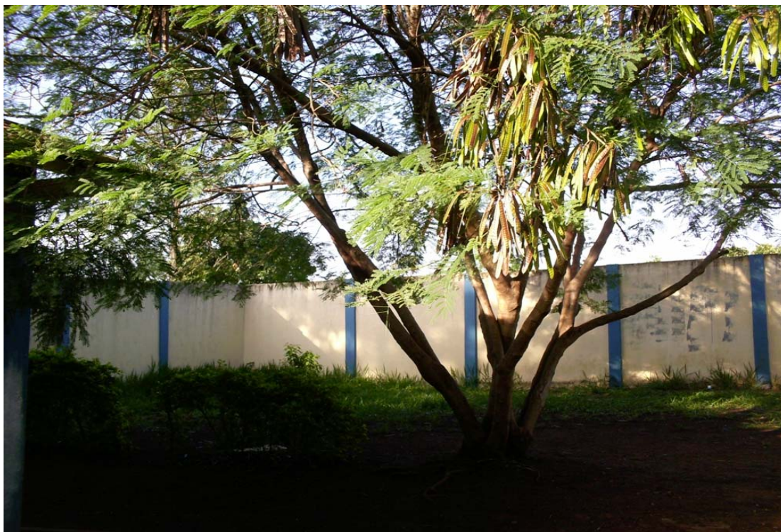
Figura 15 – Lateral da “EE Capitão Joel Miranda”
