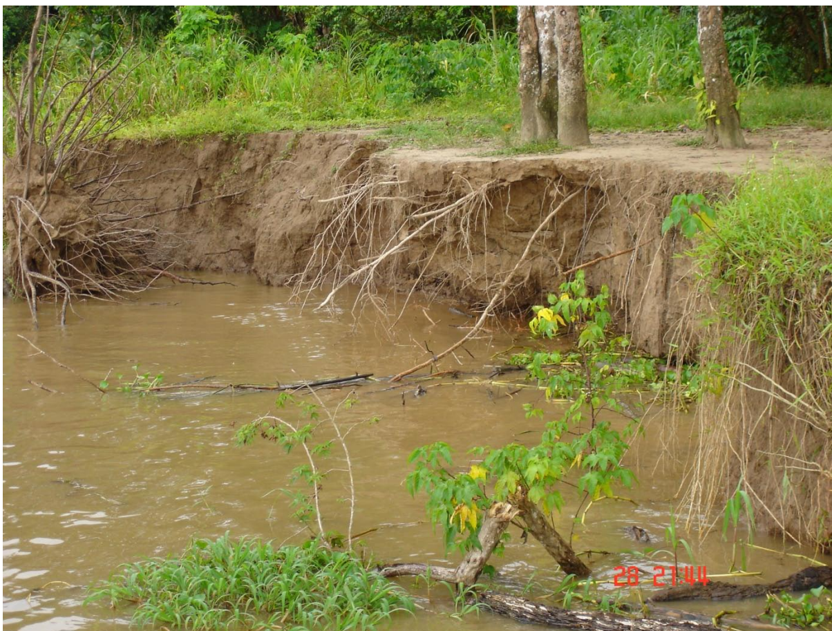
Fig. 14 – Processo erosivo ocorrendo na comunidade Santo Antônio da Terra nova.
