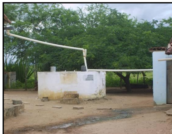
Foto 5- Solânea (PB): Cisterna de Placas. Autor: VAZ, C. F. (jun./2008)
