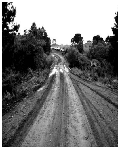
Foto 8: Chegada ao Barranco, por sobre o rio da Reserva
