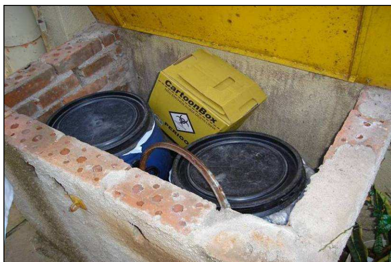
Figura 28: Armazenamento externo feito em abrigo sem condições adequadas de segurança e limpeza – Posto B, 2009.
