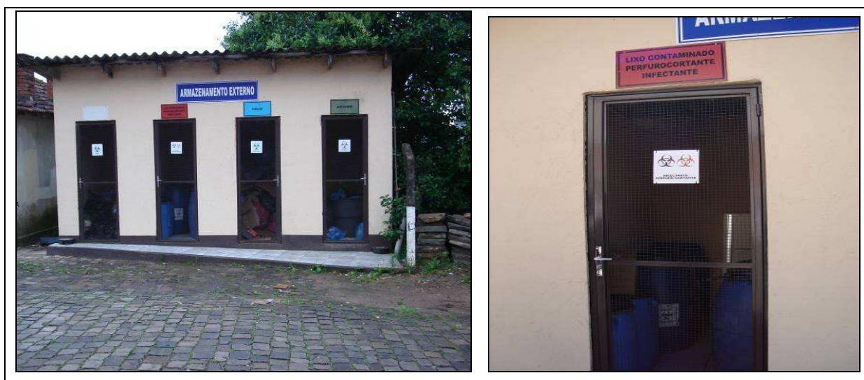
Figura 22: Depósito de Armazenamento temporário dos RSS.
