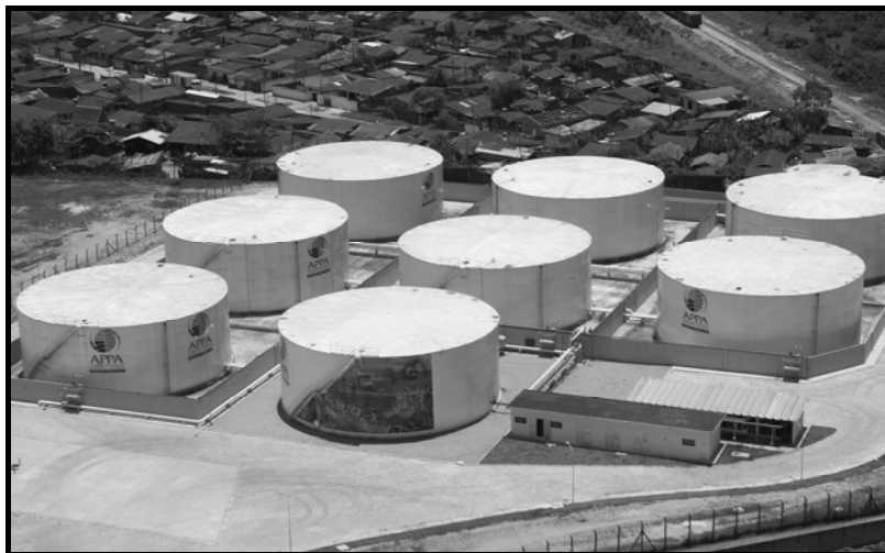
Figura 31: Vista panorâmica do Terminal Público de Álcool, administrado pela APPA
