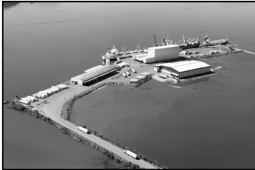
Figura 44: Vista dos Terminais Portuários da Ponta do Félix
