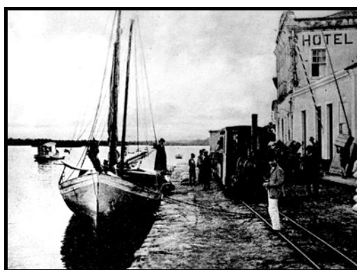
Figura 15: Documentação fotográfica relativa ao embarcadouro de Paranaguá, quando este situava-se às margens do rio Itiberê. A) Foto sem data, observando-se pequenas embarcações à vela e o transbordo manual das cargas, de forma solta ou em sacaria; B) O mesmo local no início do século XX, já com a instalação de um ramal de linha férrea. Fonte: Imagens do Acervo da APPA, cedidas pelo Conselho de Autoridade Portuária de Paranaguá (CAP)
