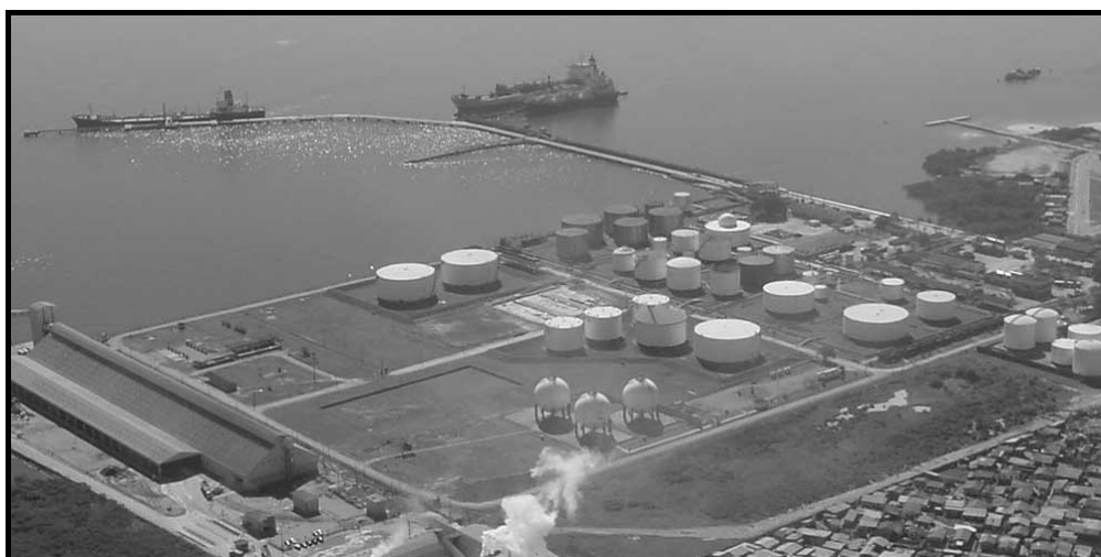
Figura 37: Vista geral do Terminal de Paranaguá da Transpetro (TEPAR), em 2008
