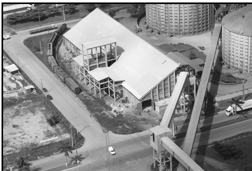
Figura 32: Vista do Terminal Público de Fertilizantes, administrado pela APPA
