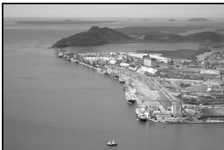
Figura 29: Vista panorâmica do Cais de Múltiplo Uso (CMU) do Porto de Paranaguá em 2008
