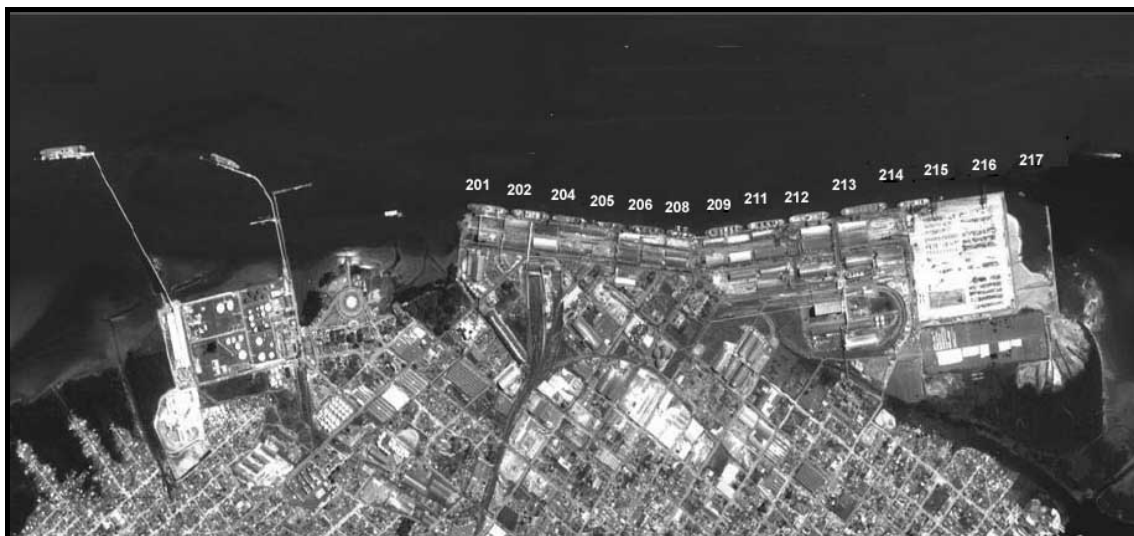
Figura 28: Berços de atracação do Cais de Múltiplo Uso (CMU) do Porto de Paranaguá
