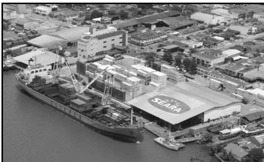
Figura 55: Vista panorâmica do Terminal Portuário da Braskarne, em 2007
