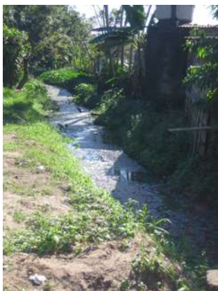
Figura 4. 7. Canal de drenagem com esgoto in natura sendo despejado
