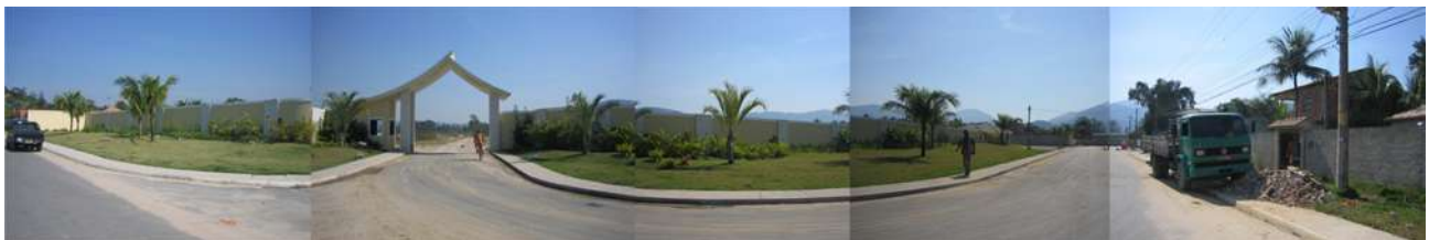
Figura 2. 14. Loteamento na área do Portinho (sujeita a alagamento)
