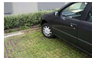
Piso poroso estacionamento
