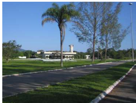
Figura 2. 25. Estrada de entrada do CTEX
