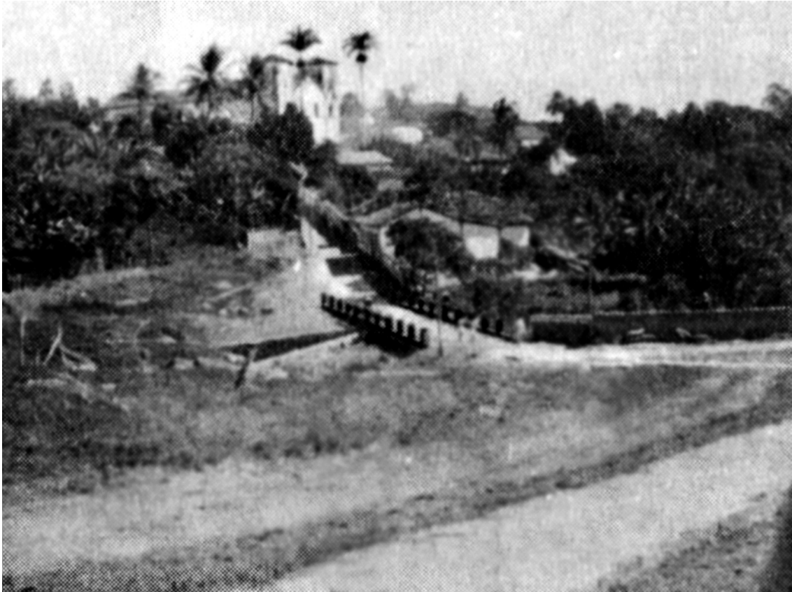
Foto: 17 Ponte de Pedra sobre o córrego da Pratinha, anterior a 1920
