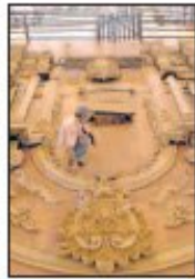
INTERIORES TRABALHOS EM RECONSTRUÇÃO DO TEMPLO E RECUPERAÇÃO DO TETO E O PISO
