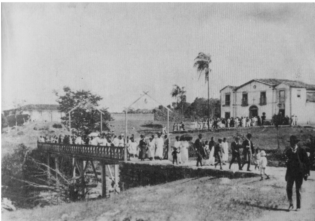
Foto: 06 Ponte do Carmo e Igreja de Nossa Senhora do Carmo, anterior a 1910
