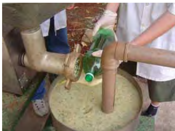
Figura 4. Inoculação das sobras alimentares com E.M. (Microrganismos Exógenos) antes de serem bombeadas para dentro do biodigestor anaeróbio. E.M. produzido pela Fundação Mokiti-Okada.
