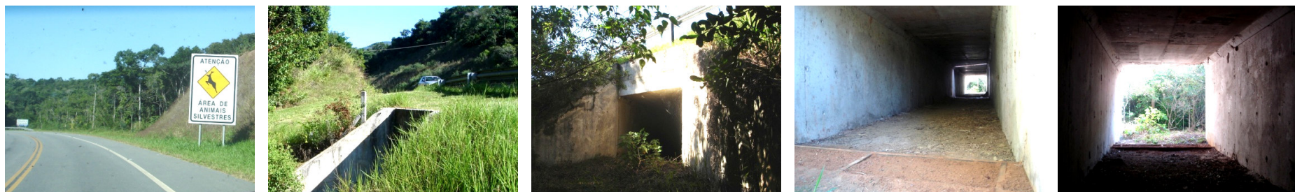
Figura 15: Travessia subterrânea para fauna silvestre na Rodovia ES 060, trecho do contorno de Guarapari (não incluída na área de estudo), construída pela empresa concessionária Rodosol.
