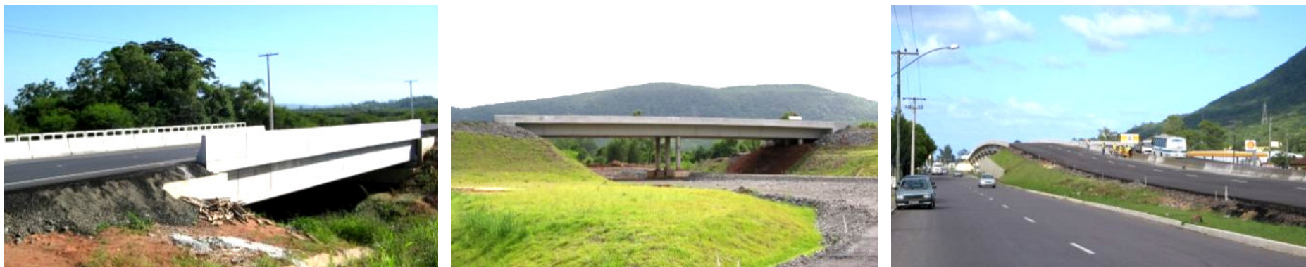
Figura 09: Obras de travessias da BR 101 Sul, da esquerda para a direita: ponte sobre o rio Esperança (km 372), viaduto de intersecção (km 71) e viaduto de acesso a Osório (km 98).
