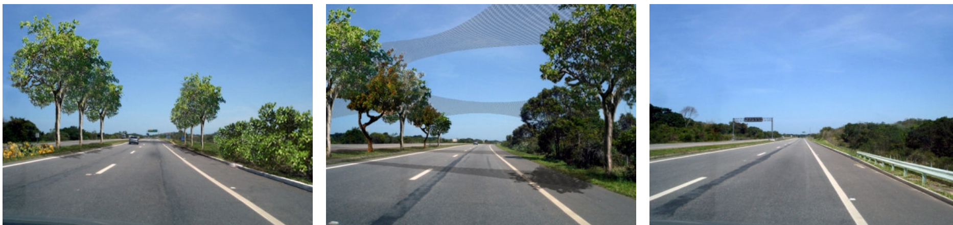
Figura 57: Outros modelos desenvolvidos: travessia para animais arborícolas e terrestres com árvores e arbustos (à esquerda), travessia para animais arborícolas com árvores e redes auxiliares (ao centro) e travessia subterrânea para animais terrestres (à direita).
