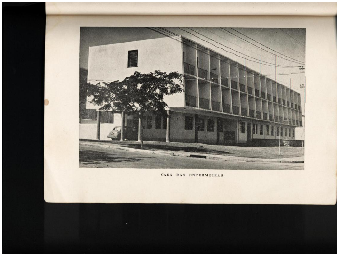
Foto n.º 5: Residência das enfermeiras do Hospital da Companhia Siderúrgica Nacional localizada no bairro Vila Santa Cecília, Volta Redonda, atual Centro Médico do Hospital VITA. Fonte: SILVA, 1956, p.35.
