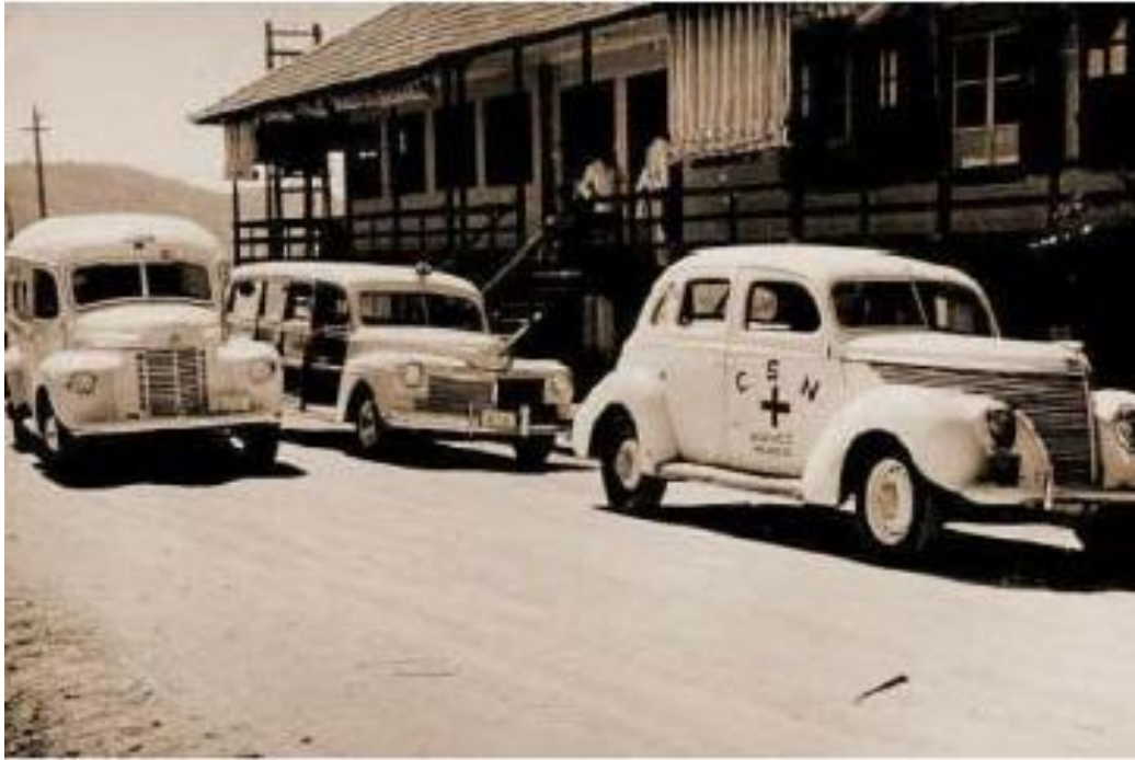
Foto n.º 2: Edificação de madeira que foi construída em 1942, à margem do Rio Brandão, no extinto Bairro Acampamento Central, em Volta Redonda, e que acomodava o Serviço de Saúde da CSN.
