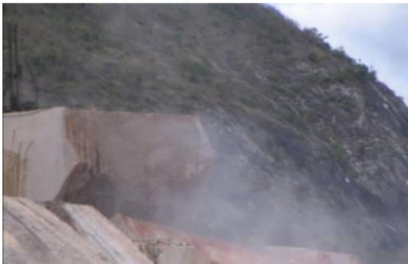
*Figura 23 e Figura 24 - após a queima do estopim ocorre a queda da bancada.*
