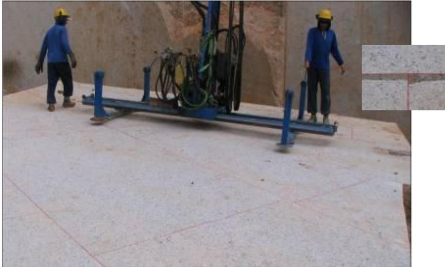
*Figura 25 e Figura 26 – trabalhadores posicionando a perfuratriz conforme esquadrejamento realizado e tamanho dimensionado no detalhe*
