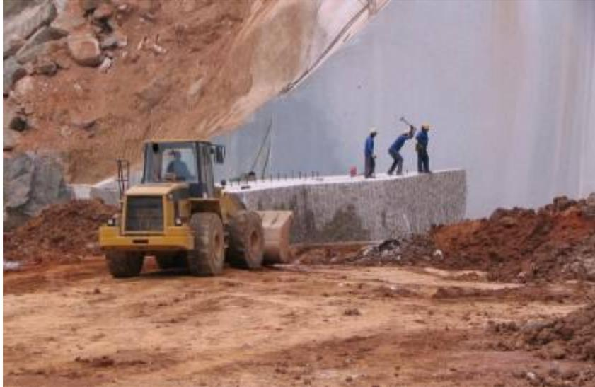
*Figura 28 – abertura de cortes para desmembramento da prancha e individualização do bloco.*
