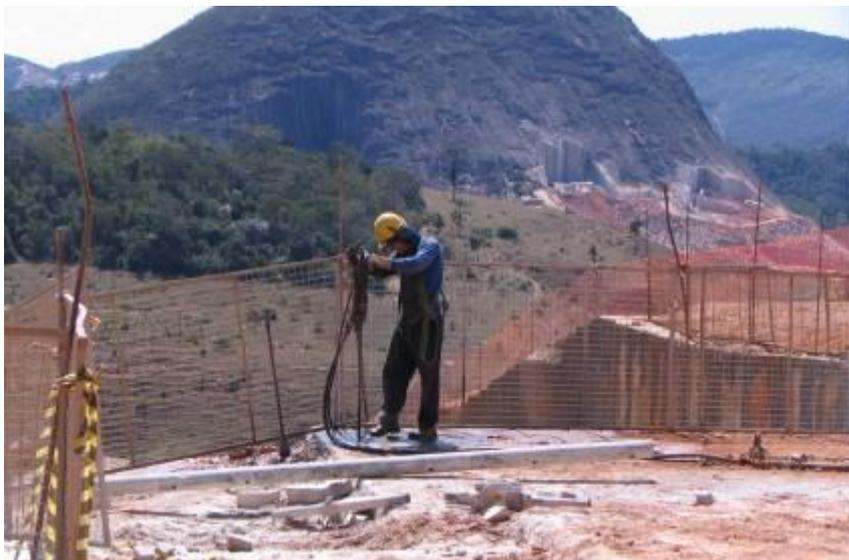
*Figura 22 – marteteleiro preparando o filão, prancha ou bancada para preenchimento com o cordel detonante.*
