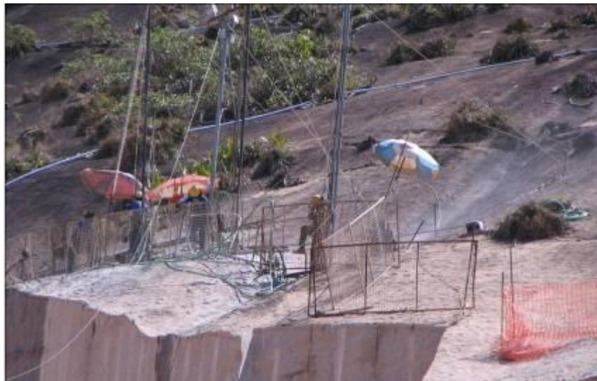
*Figura 19 e 20 – Cortes na rocha para isolamento*
